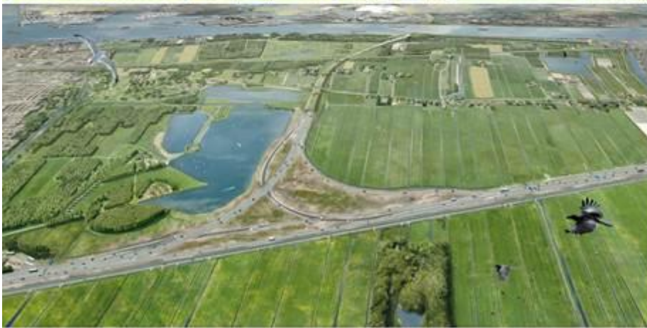
Midden Delfland mèt Blankenburgtunnel: asfalt verdringt natuur
